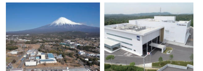
フジヤマ工場
